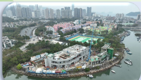
新沙頭角污水處理廠 (航空照片) New Sha Tau Kok Sewage Treatment Works (Aerial Photo)
